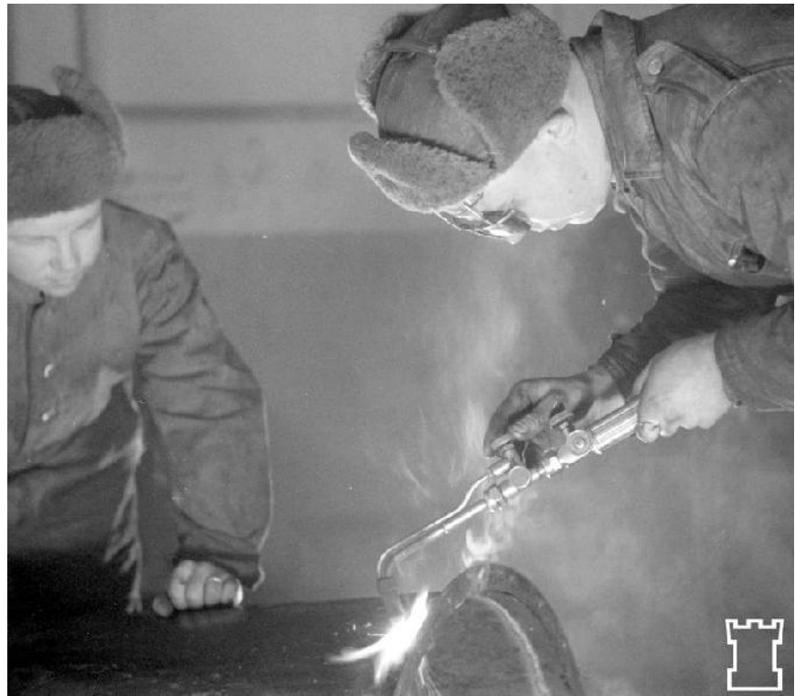
Häkäpöntön hizailua. Welding Wood stove /gas generator parts.
