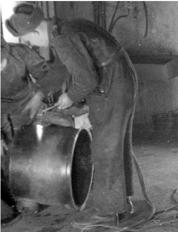
Häkäpöntön hizailua. Welding Wood stove /gas generator parts.
