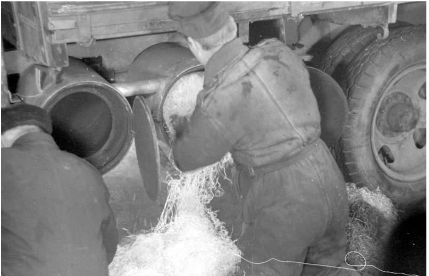
Tässä karjalan kuusipukille nousikin vee-kaheksikko. Wood stove /gas generator repair. Alla: Häkäpönttöä hiotaan.
