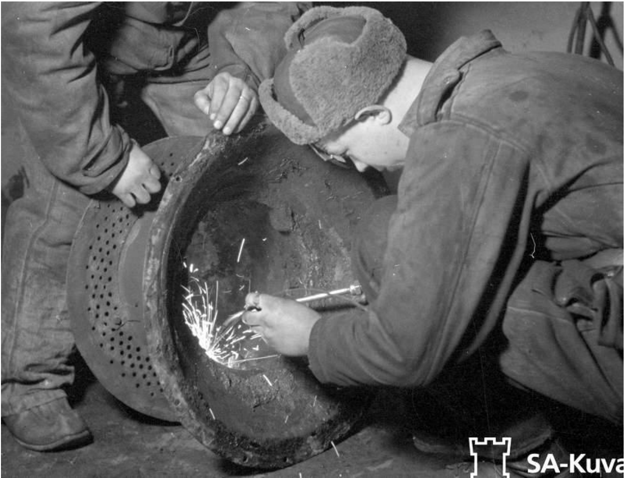
Häkäpöntön tulipesän sisäosien korjaus. Wood gasifier drum needs welding.
